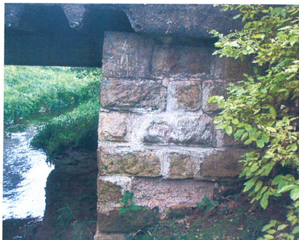
rozpadlý kamenný kvádr do hloubky cca 5-7cm na boku opěry na konci mostu vpravo
