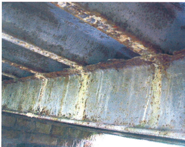
téměř překorodované horní pásnice ocelových I nosníků v místech dodatečně uložené mostovky ze štětov
