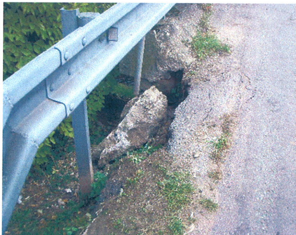
detail utržené zpevněné části krajnice v předpolí mostu
