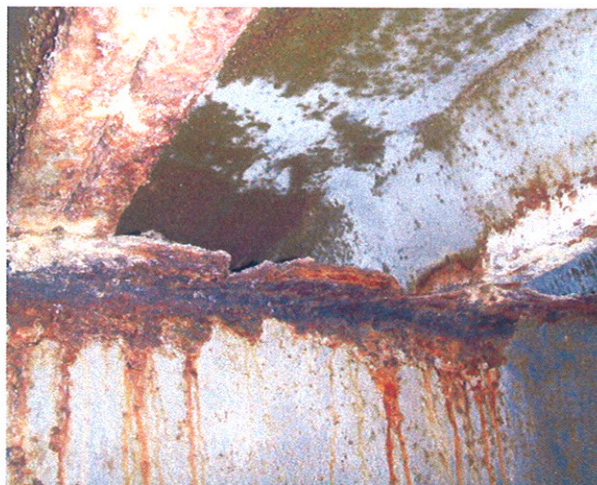
detail horní pásnice ocelových I nosníku
