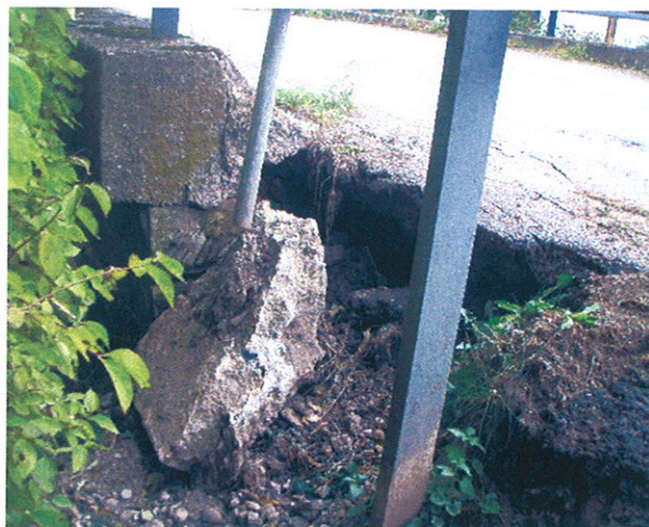
rozpadlé zakotvení ( utržené ) svodidla a sloupku dopr. značení v předpolí na začátku mostu vlevo
