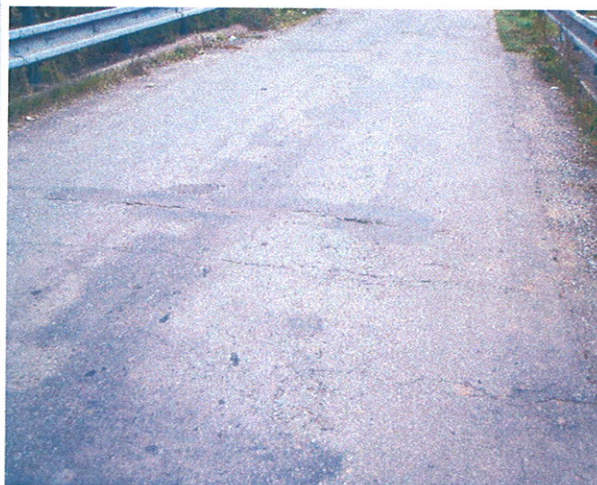
příčné praskliny v živičném krytu vozovky na mostě
