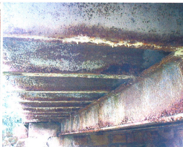
protékající spáry ( s inkrustacemi ) mezi jednotlivými ocelovými příčnými profily mostovky
