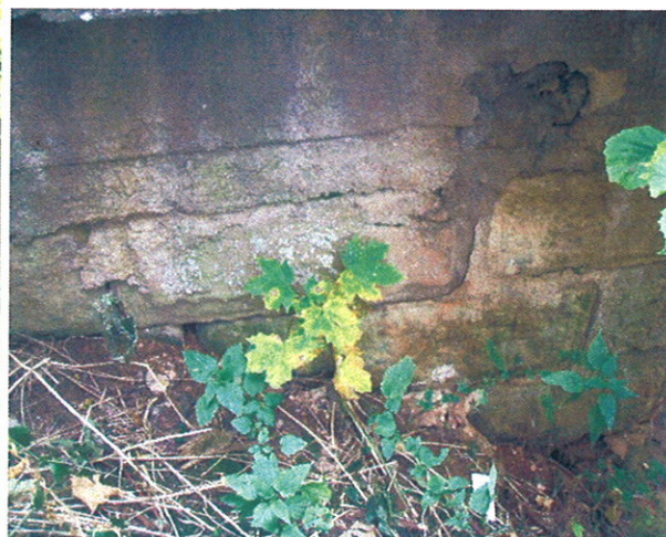
uvolněné kvádry a vodorovné trhliny na opěře
