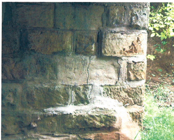
nově vzniklé původní trhliny po dodatečné opravě a přespárování kamenných kvádrů
