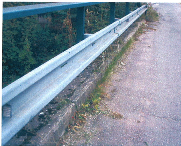
zakořeněná vegetace pod obrubníkem a lišejníky na povrchu mostní římsy
