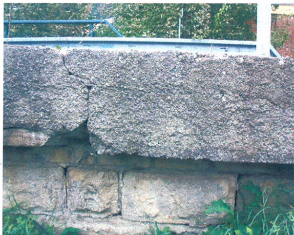
příčná prasklina v železobetonové římse na konci mostu vpravo
