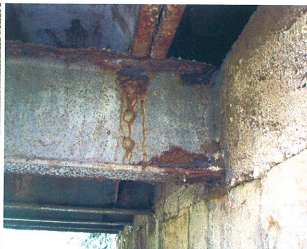
100% překorodované pásnice levého krajního ocelového I nosníku v místě vetknutí
