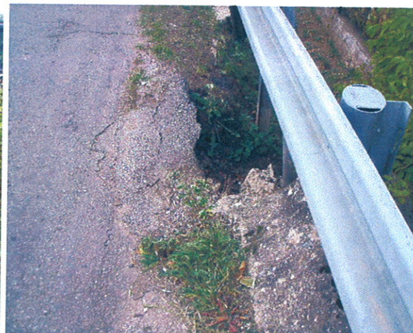
utržená zpevněná živičná krajnice (pohled proti směru staničení)
